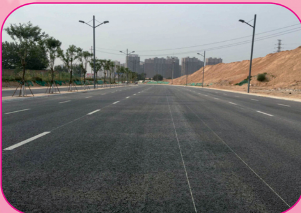
东峰路道排工程
