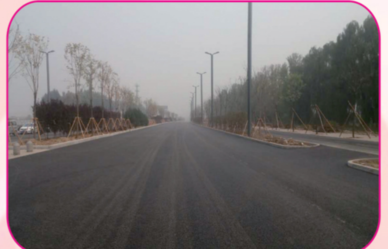
太茅路道路工程
